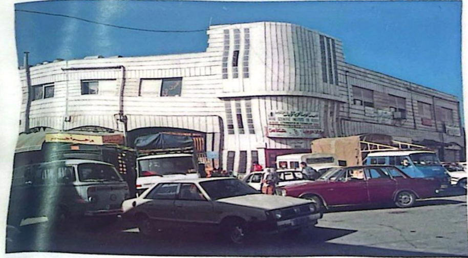
مبنى سوق الخضار في المدينة.
